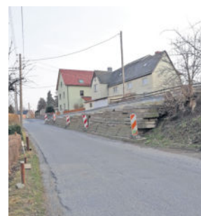
Seit 2012 existiert das Betonprovisorium.
