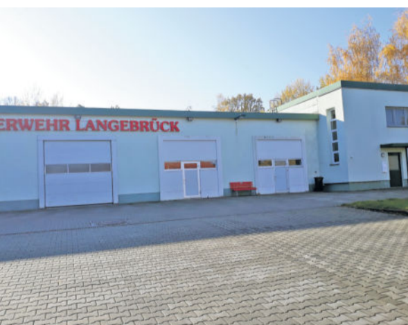
Das Gerätehaus der Feuerwehr ist zu klein. In den Jahren 2022 / 2023 soll ein Erweiterungsbau entstehen.
