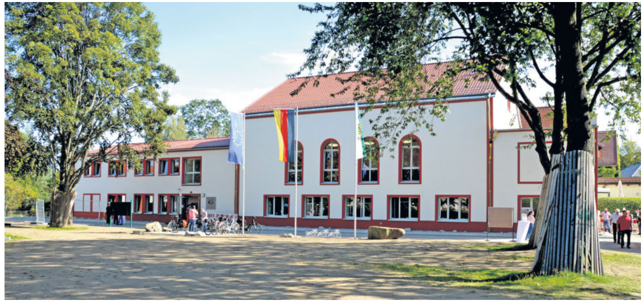
Sanierung und Erhalt: Statt Altes abzureißen wurde die Bausubstanz erhalten und dient nun als Dorfgemeinschaftshaus mit Gemeindeverwaltung.
