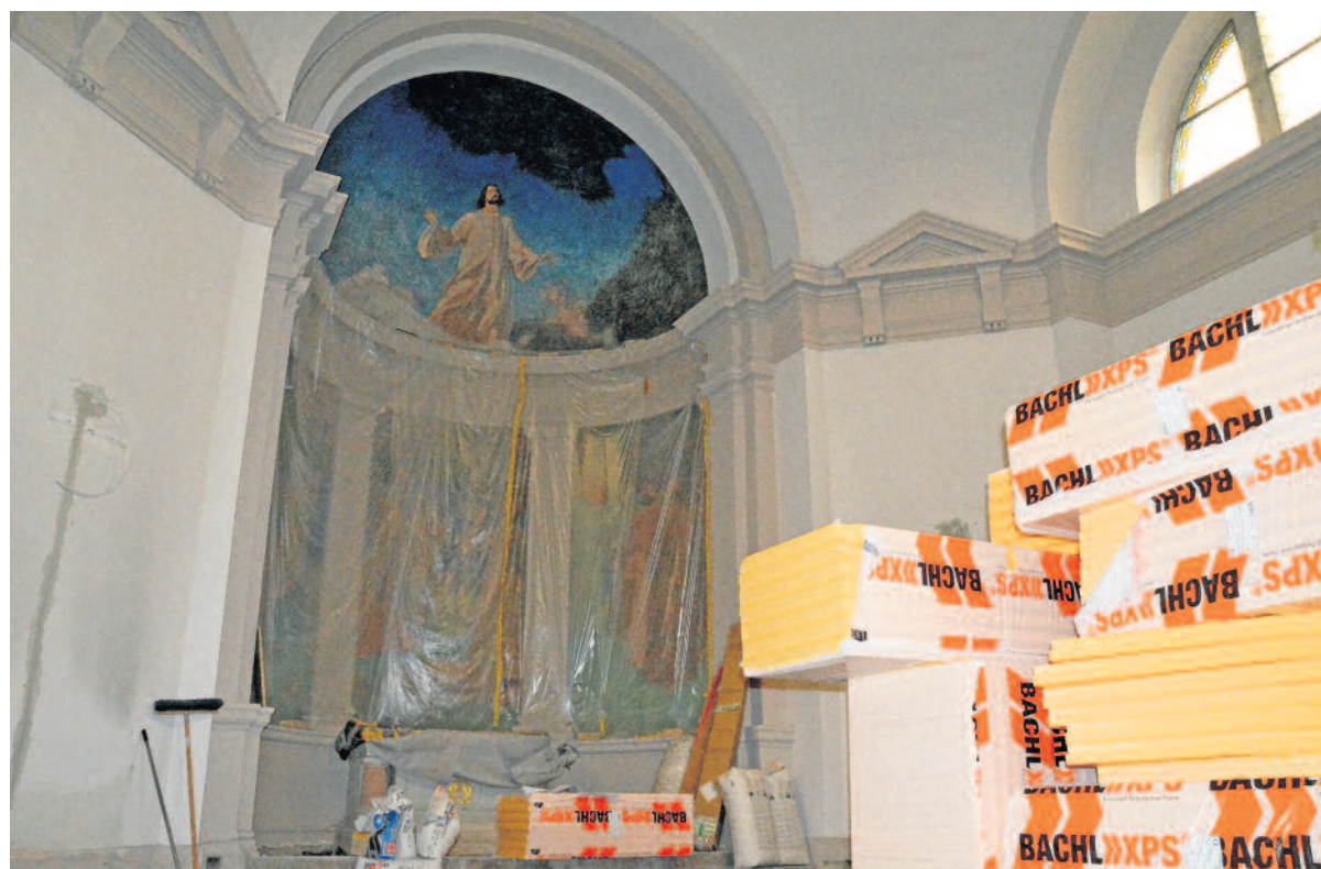
Das Altarbild ist während der Baumaßnahme abgehängt, es bleibt erhalten.
