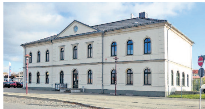
Bahnhof Bischofswerda (Straßenseite) - Duplikat des Radeberger Bahnhofes von 1845. Der Scheingiebel an der Straßenseite ist erhalten geblieben.
