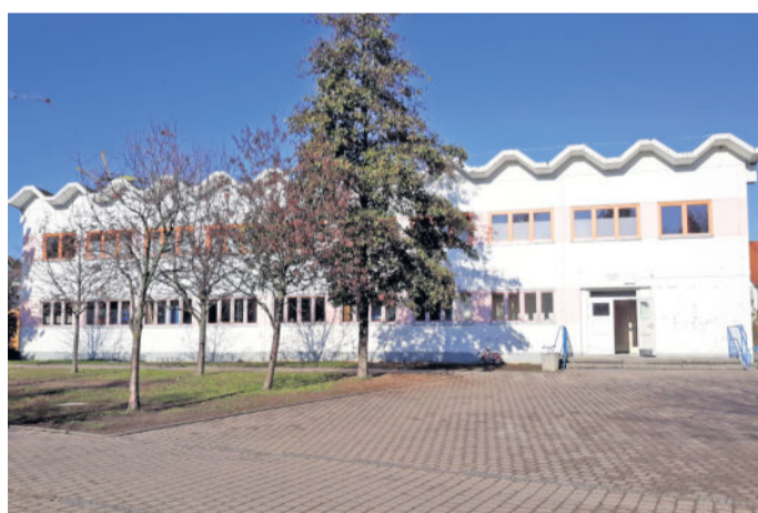
Die Turnhalle auf dem Grundschulareal soll durch eine moderne Zweifeldsporthalle ersetzt werden.
