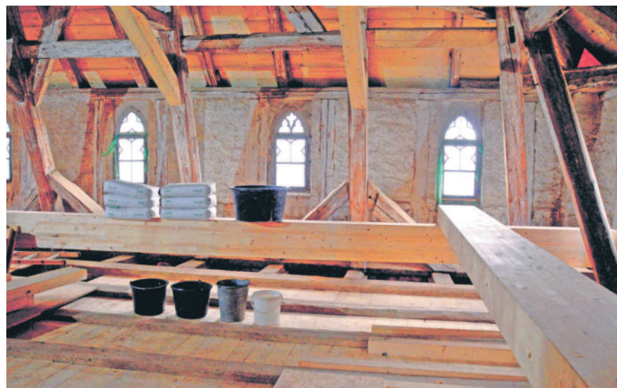
Der erste Bauabschnitt der Dachsanierung ist in vollem Gange.
