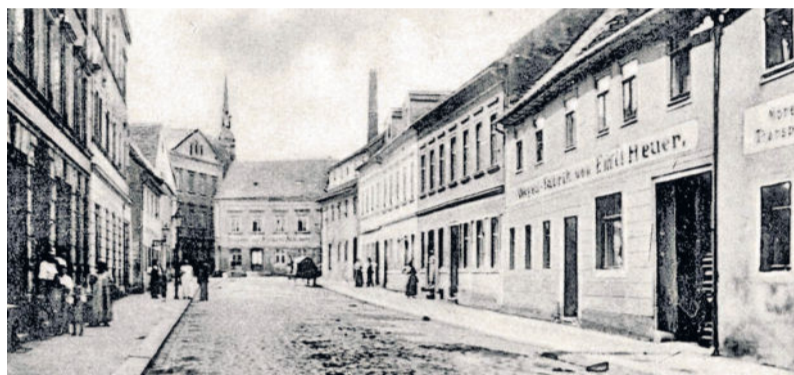
Emil Heuers erste Werkstatt im Hinterhof des damaligen Grundstückes Pulsnitzer Straße 4. Die Straße war noch nicht durchführend. Alte AK.
