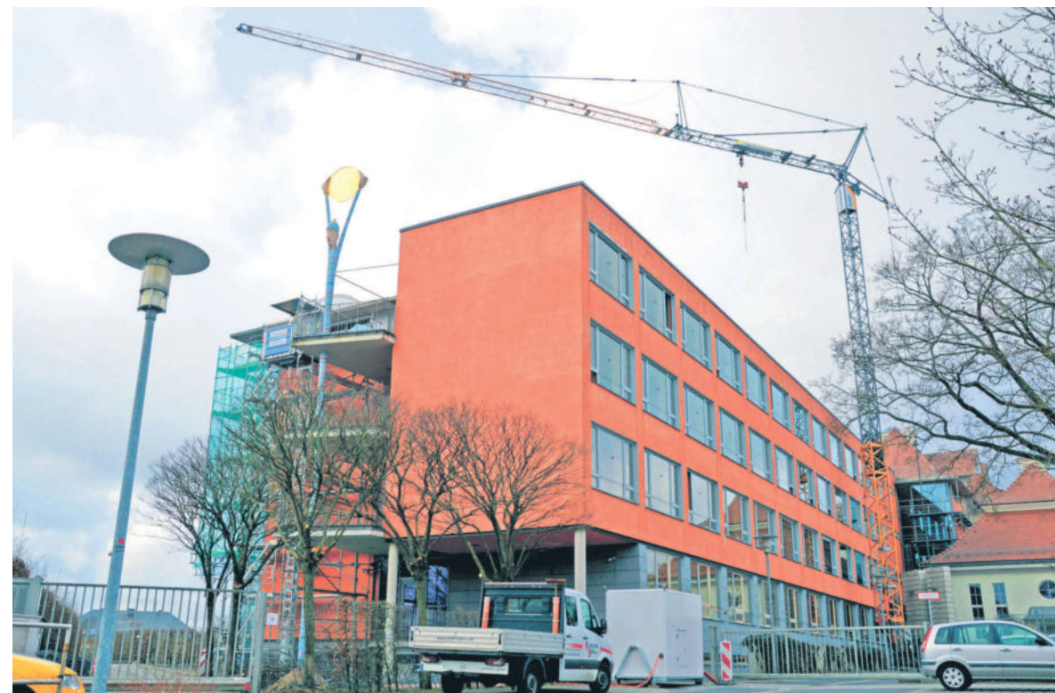
Auf der Dachterrasse des Humboldt-Gymnasiums entsteht gerade ein Anbau mit zusätzlicher Raumkapazität.
