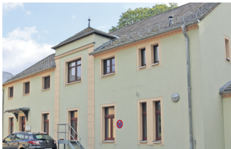
Im Erdgeschoss des Nebengebäudes in der Weißiger Straße ist nunmehr die Ortschronik zu finden. Bisher gibt es hier keinen Internetanschluss. FOTO: Archiv Gebauer
