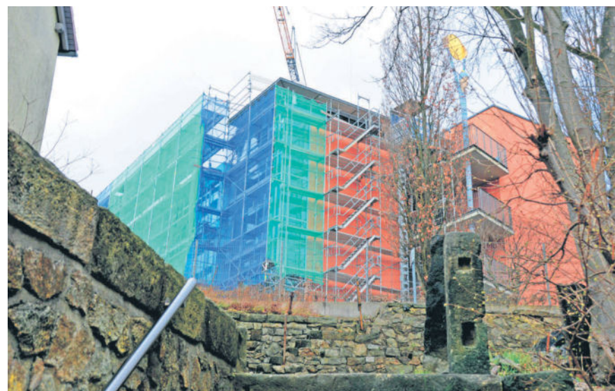
Die Arbeiten auf dem Freudenberg sollen zügig abgeschlossen werden.
