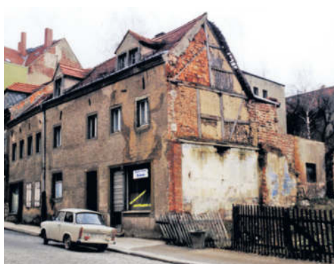
Foto links: Abriss der Gebäude Hauptstraße 33 & 35 im Jahr 1994.
