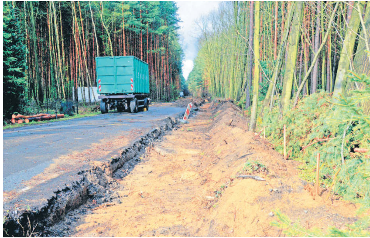
Bereits 2017 wurde ein Teilstück der Kreisstraße zwischen Lomnitz und Ottendorf-Okrilla saniert.
