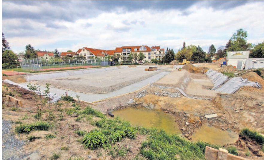
So sah es auf der Baustelle im Mai 2023 aus.
