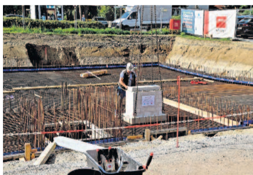
Nachdem der Grundstein mittels Kran zur Baustelle transportiert und später genau nach Plan eingemauert wird, kann weiter an den Häusern der Richard-Wagner-Straße 7-13 gebaut werden.
