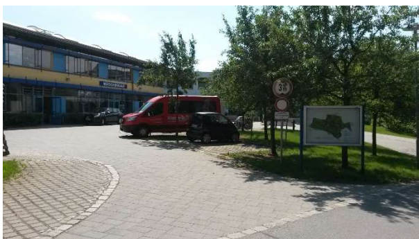
Foto 5: bestehendes Sondergebiet der Kleinwachauer Werkstätten
