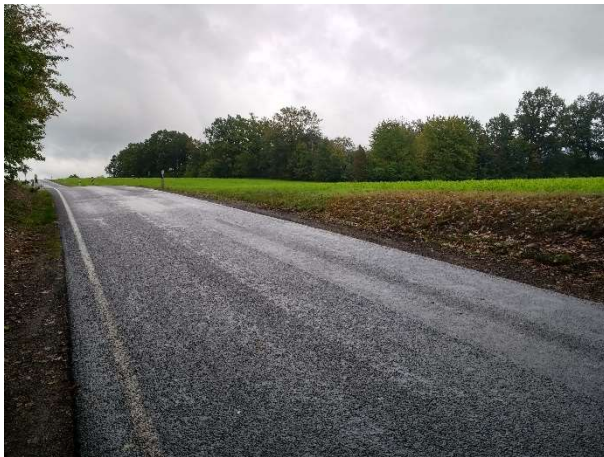
Foto 3: Kreisstraße K 9257 am westlichen Plangebietsrand und Gehölzstreifen am östlichen Plangebietsrand, dazwischen Ackerland
