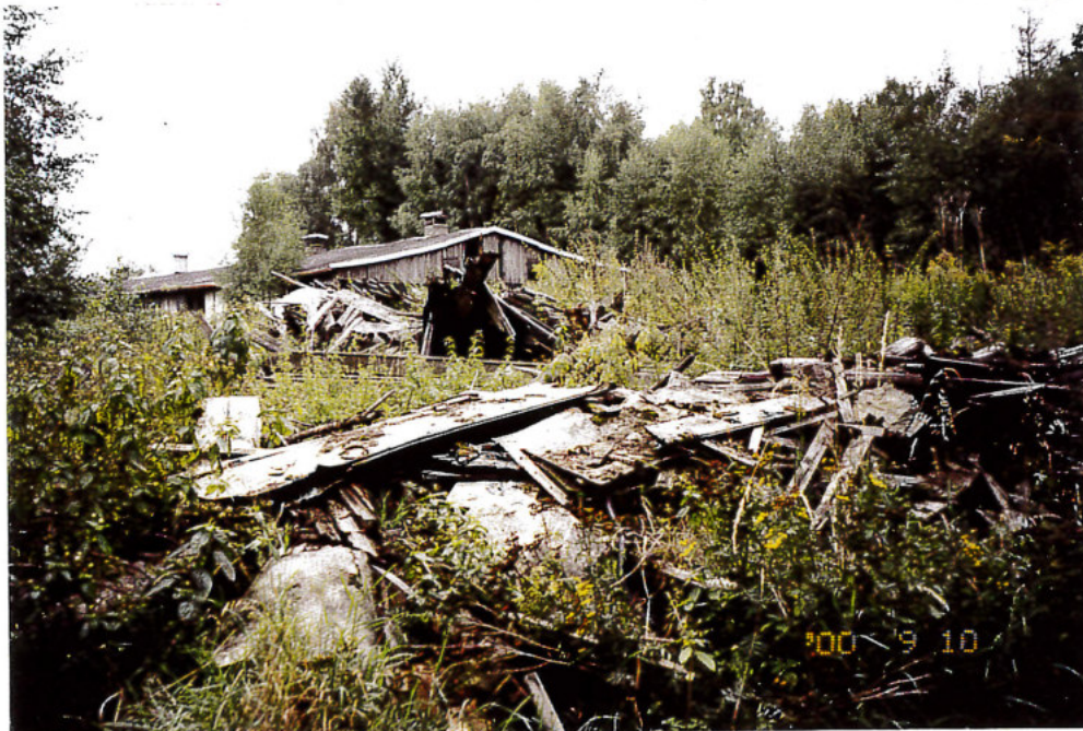
Bild 8 Holzablagerung hinter dem Gebäude 2
