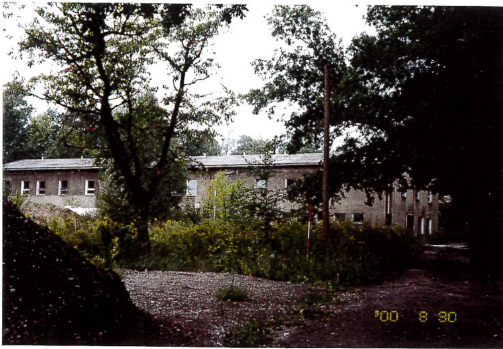
Bild 1 Blick auf des Sozial- gebäude mit Brüterei und Heizung
