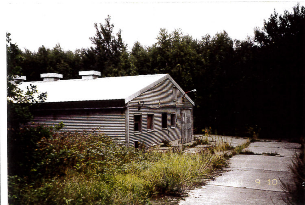
Bild 6 Befestigter Weg vor den Ställen mit Kanalsystem unter den Betonplatten
