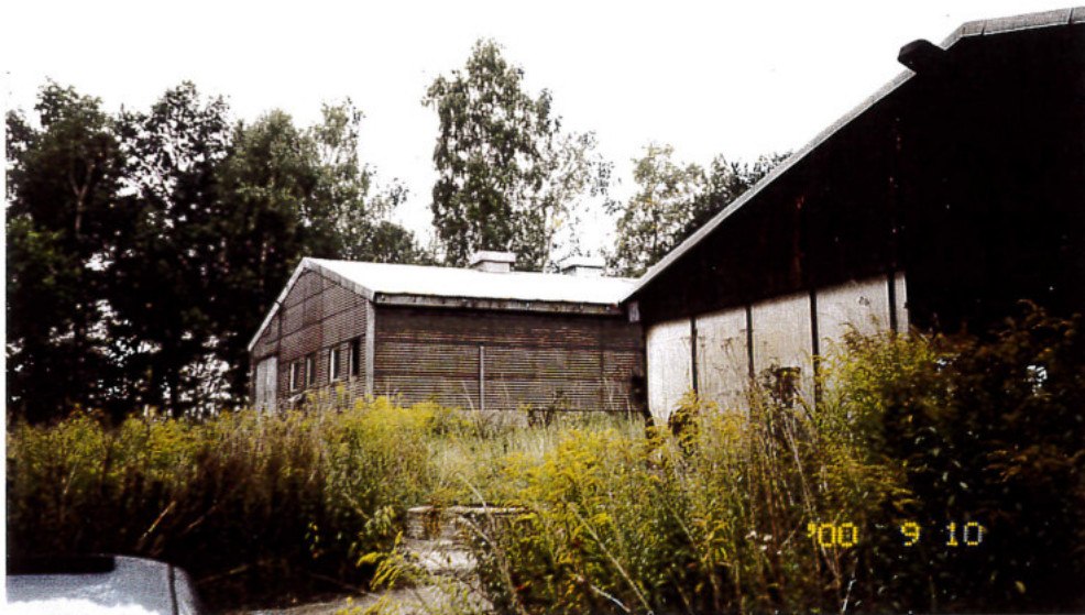
Bild 4 Blick vom Nordosten auf die Ställe (Gebäude 1 +2)
