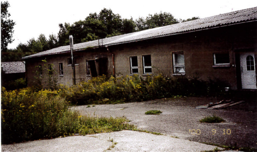
Bild 2 Blick vom NW auf das Sozialgebäude
