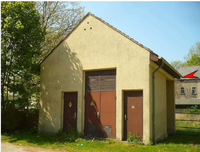
Trafohaus (T) Ansicht von Osten mit Lage der Wochenstube im nord-westlichen Teil des Gesimskastens. Insgesamt wurden am 21.05.2014 zwischen 21:19 und 21:30 Uhr 37 ausfliegende Zwergfledermäuse gezählt.
