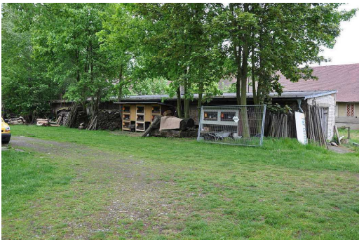
Ansichten abzubrechende Gebäude I-7 (von Norden)
