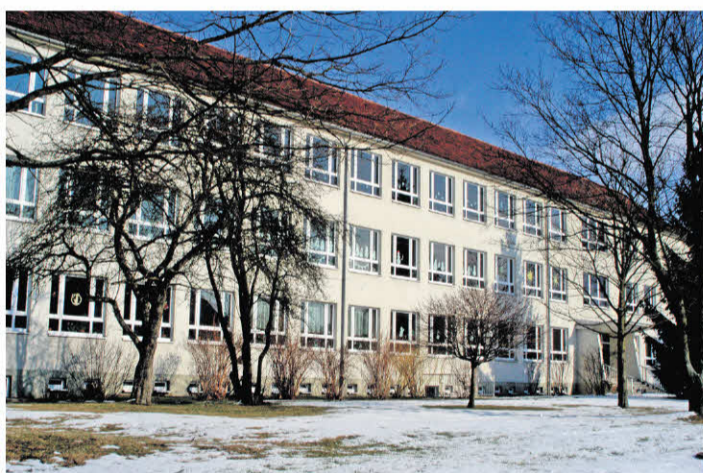
Die Komplettsanierung der Grundschule Süd ist eines der Großprojekte für 2019/2020.
