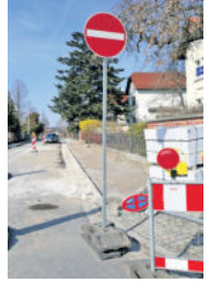
Aktuell läuft die Sanierung auf der Jakob-Weinheimer-Straße.
