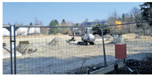
Am Kinderzentrum haben Tiefbauarbeiten begonnen. FOTOS: Gebauer
