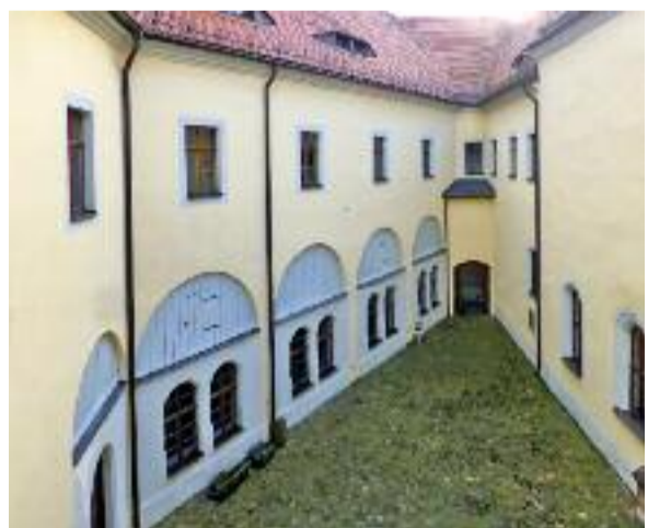
Der Innenhof nach der Sanierung
