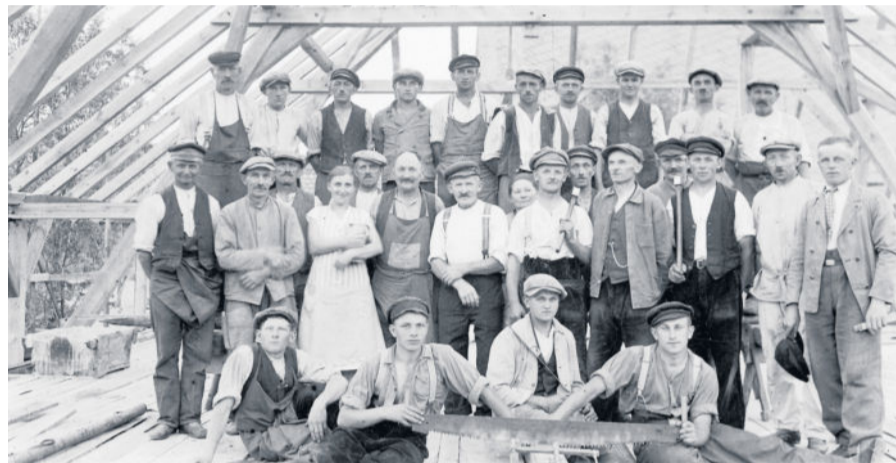
Ende August 1928 wurde Richtfest gefeiert, sodass noch im Oktober im Saal die Kirmes mit einem großen Fest begangen werden konnte.
