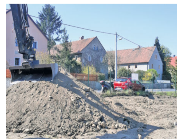
Das Areal in der Hauptstraße wurde vorbereitet.
