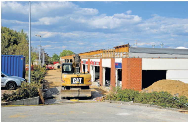
Ende April wurde der Wandel zum Silberberg Center auch äußerlich sichtbar. Große Baumaschinen rissen weg, was nicht mehr gebraucht wurde.
