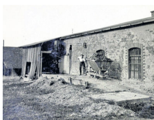
Lehmtransport mit der Feldbahn. Quelle: df_hauptkatalog_0001124
