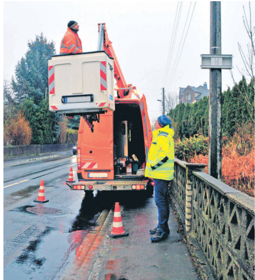
Am 10. und 11. März 2021 wurden die drei Tafeln in Feldschlößchen und Seifersdorf montiert.
