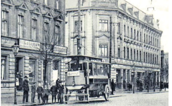
Die gleislose „elektrische Oberleitungsbahn“ in Eberswalde 1901, wie sie dem Radeberger Stadtrat empfohlen wurde. Zu beachten ist die sehr hoch angebrachte Oberleitung mit einem „Stromabnehmer-Wagen“ (rechts oben). Foto: Wikimedia gem.-frei
