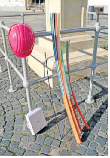
Für den direkten, kostenlosen Hausanschluss ist die Genehmigung durch den Eigentümer notwendig. Weitere Informationen zur Anmeldung folgen in den nächsten Wochen.
