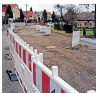
Die Deckschicht wird hier erneuert. FOTO: Gebauer
