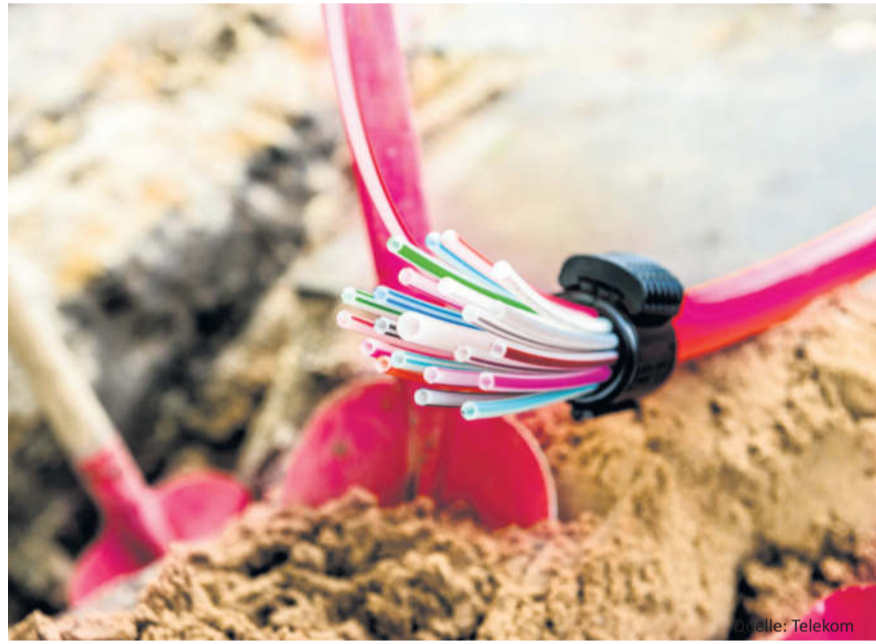
Für rund 3.400 Haushalte in Radeberg baut die Telekom ihr Glasfasernetz aus.
