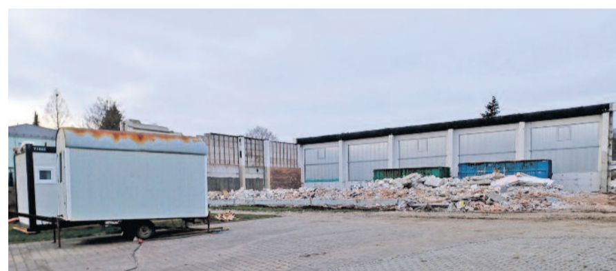
Die Fotos dokumentieren eindrucksvoll die Abrissarbeiten.
