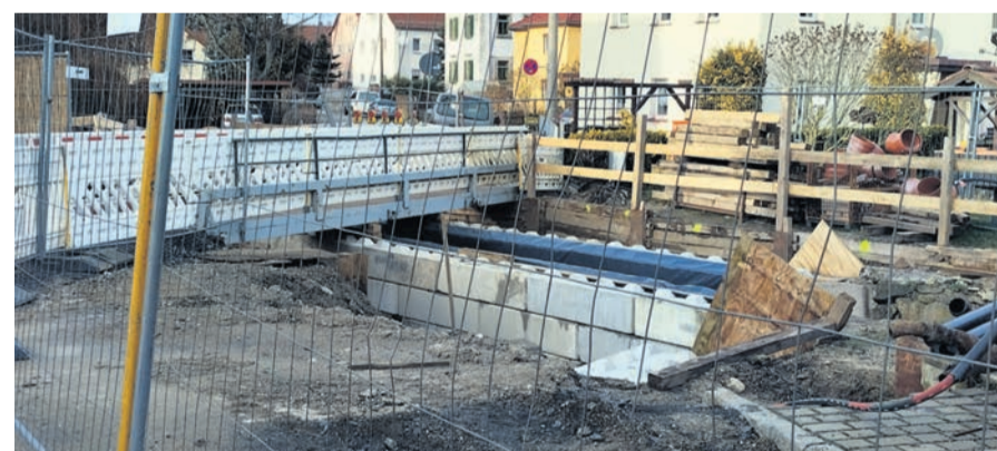
Seit dem 16. Dezember 2022 ist Baustopp. Eine Fußgängerbrücke wurde errichtet, für den Fahrverkehr ist die Durchfahrt weiterhin gesperrt.
