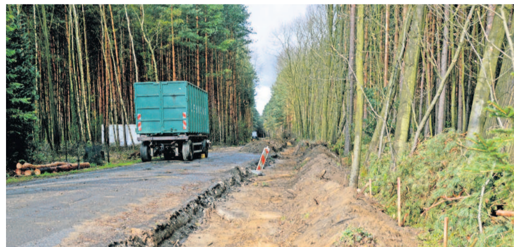
Der erste Bauabschnitt wurde 2017 bereits realisiert. (Foto: Red. Archiv)
