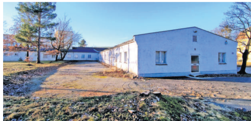
In dem Flachbau sollen Umbau- und Sanierungsarbeiten dafür sorgen, dass der Schulbetrieb im Sommer starten kann.
