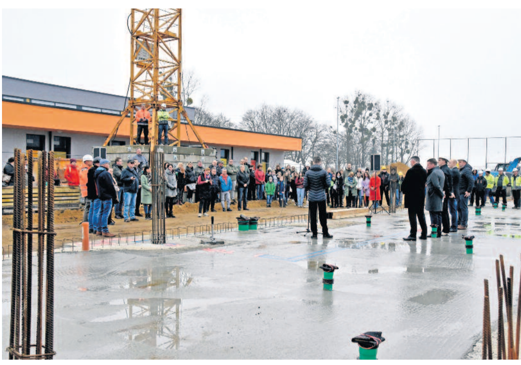
Das Fundament ist bereits gegossen und die Bauarbeiten in vollem Gange. Zur Grundsteinlegung waren neben dem Verwaltungsteam der Gemeinde, Kindern der benachbarten Grundschule, dem Landrat und seinem Team sowie Mitarbeiterinnen und Mitarbeiter der Planungs- und Baufirmen auch etliche interessierte Gäste gekommen.
