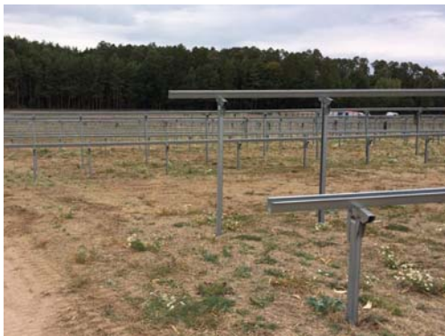
Abb. 9: Modulaufständigung
