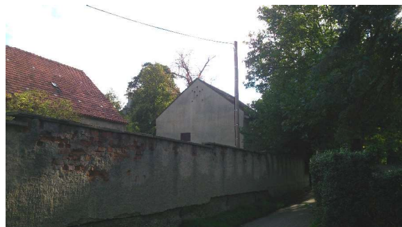
Foto 8: ehemaliges Trafogebäude, Westseite
