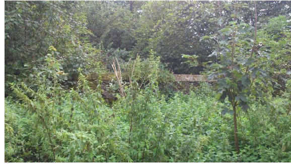
Foto 16: Die Natursteinmauern sind im Norden des Plangebietes großteils durch dichten Gehölzaufwuchs verschattet.
