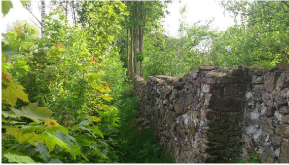
Foto 15: Natursteinmauer am westlichen Rand des Plangebietes
