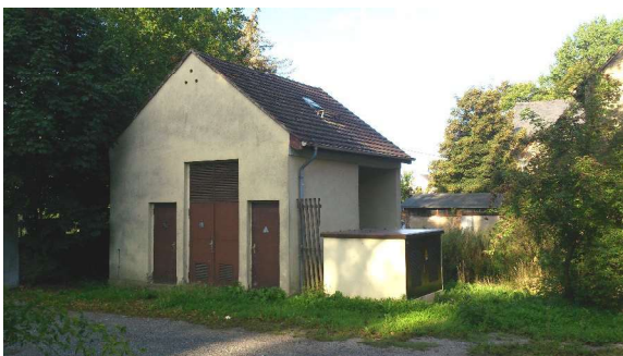
Foto 7: ehemaliges Trafogebäude, Ostseite
