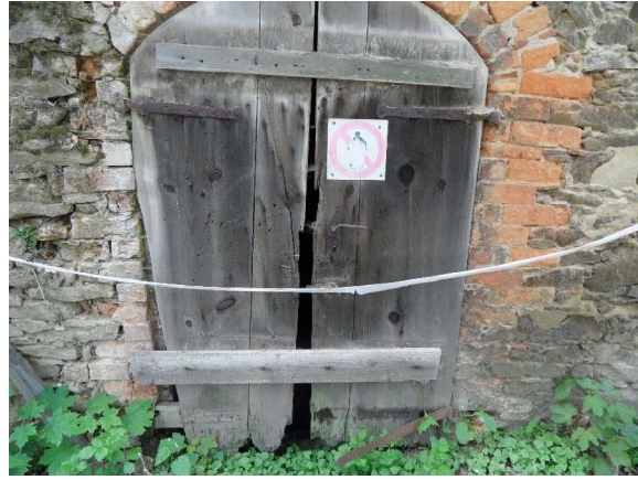
Foto 4: Zugang zum ehemaligen Eiskeller an der Ostseite
