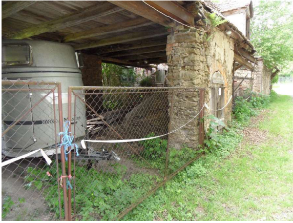
Foto 3: Garage mit Zugangsbauwerk zum ehemaligen Eiskeller
