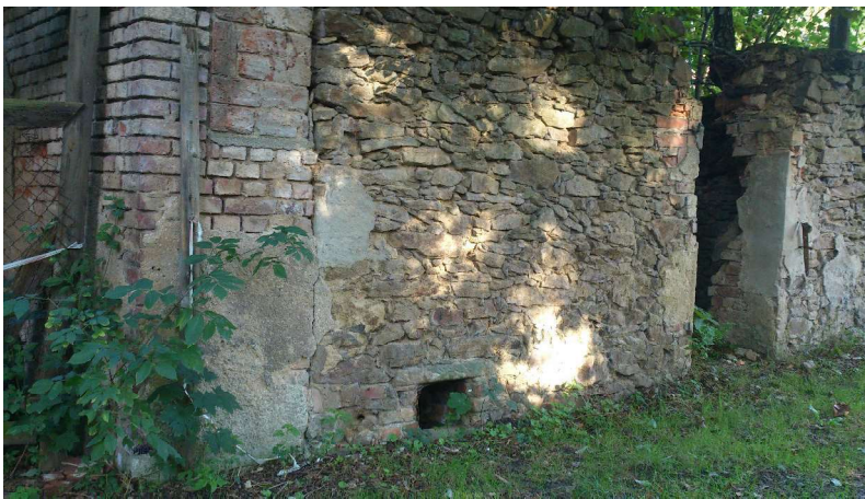
Foto 5: Lüftungöffnung des Eiskellers an der Ostseite
