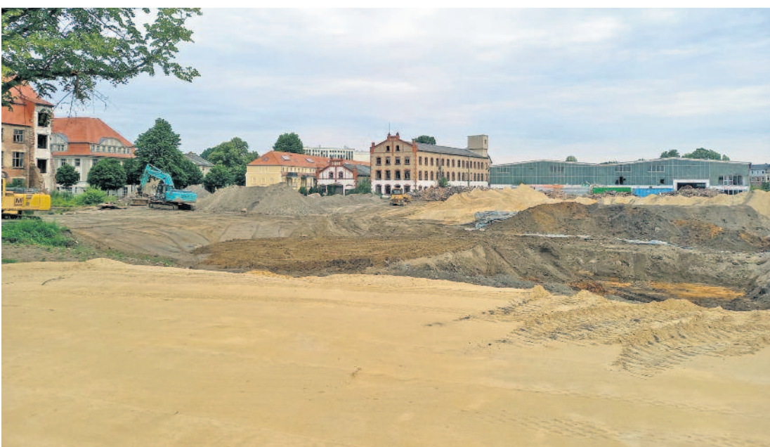
Die Baufeldfreimachung an der Bahnhofstraße auf dem ehemaligen Eschbach-Areal erfolgte bereits im vergangenen Jahr. Der Baustart für die neue Außenstelle verzögerte sich jedoch und kann nun erst zum Ende dieses Jahres erfolgen.
