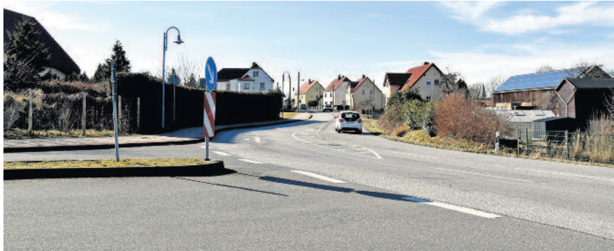
An der alten S 95 durch Leppersdorf ist es mit Eröffnung der Ortsumfahrung ruhiger geworden. Trotzdem rollen laut den Einwohnern des Öfteren noch Lkw durch den Ort.
