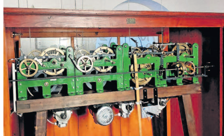
1912 wurde die Sächsische Landesanstalt eröffnet. Auf dem Gelände befindet sich ebenfalls eine Turmuhr.
