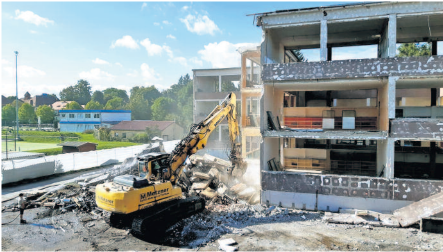
2023 – Abriss der Plattenbauschule, des vierten Arnsdorfer Schulgebäudes.
