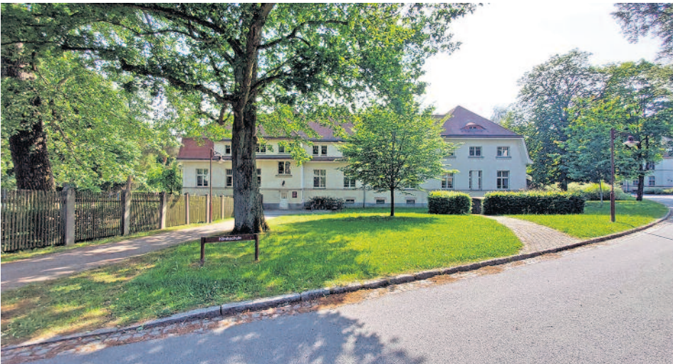
Die Regenbogenschule (Gebäude A1).
