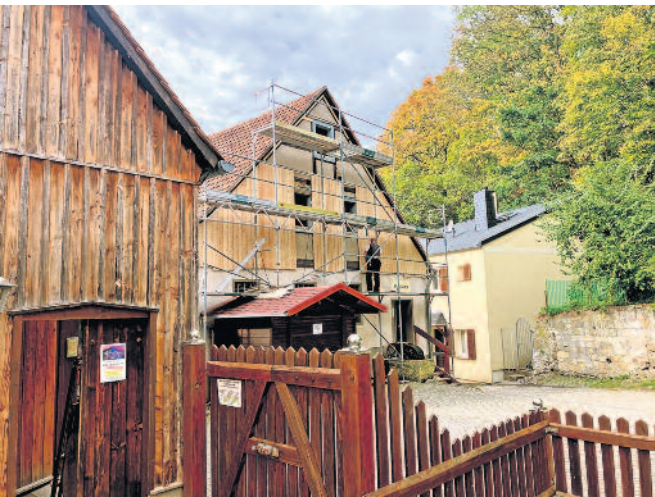
Aktuell wird am Giebel der Schloßmühle fleißig gewerkelt.
