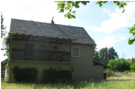
Abb. 6: Ehemaliges Bestandsgebäude auf dem Plangebiet (östliche Gebäudeansicht)
