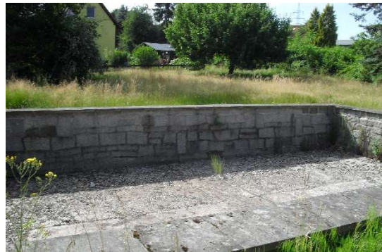
Abb. 7: Ehemalige Bestandsversiegelung auf dem Plangebiet (Blick nach Westen)
