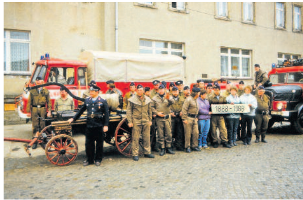
1988: erhielt die Feuerwehr einen neuen Robur LO2002 als LF8-TS8-STA.
