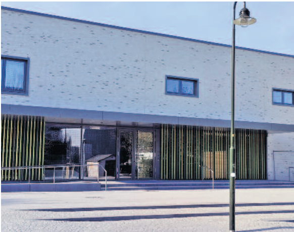
Fertig sieht die Halle von außen aus. Doch im Inneren gibt es ein gravierendes Problem.
