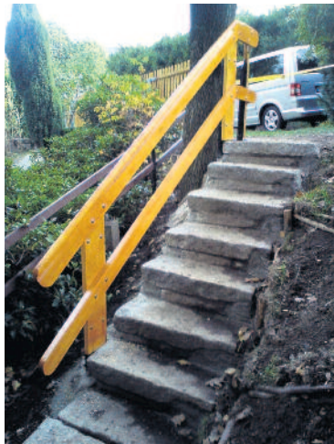
Bau der Zugangstreppe am Gutsfriedhof
