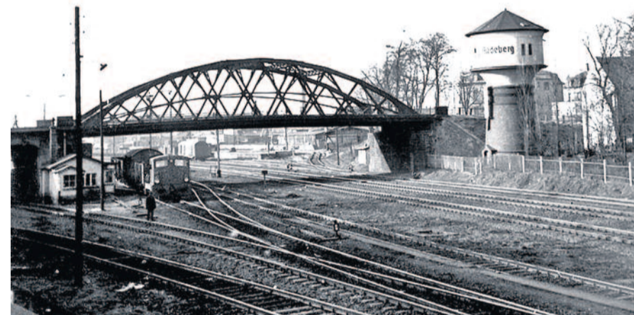
Aufnahme der Brücke nach der Erweiterung mit zusätzlichem Brückenpfeil für drei weitere Gleise des Güterbahnanschlusses.
