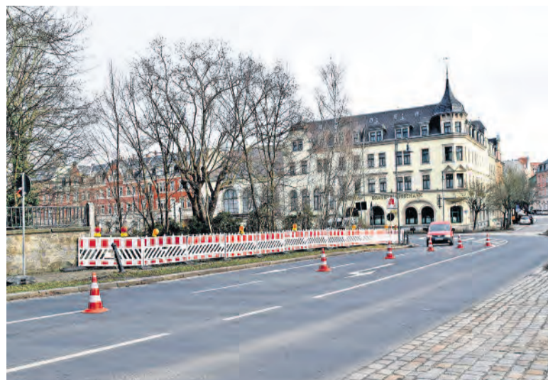
Die Brücke an der Dresdener Straße ist marode und muss saniert werden. Die Planungen dazu laufen seit 2017. Seit über einem Jahr ist nun noch eine weitere Brücke in Radeberg in den Fokus gerückt.
